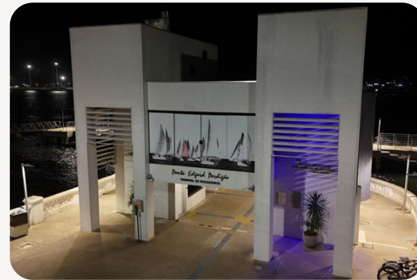
Ponte Edgard Perdigão Santos/SP | Foto: Alberto Guijen (Drone Nacional)
