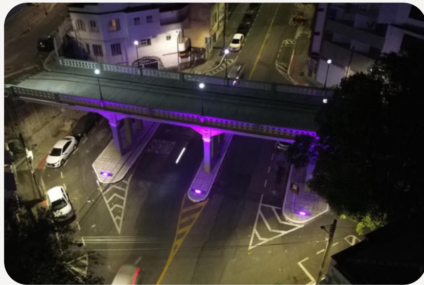
Viaduto Caramuru Vitória/ES | Foto: Robson Luiz
