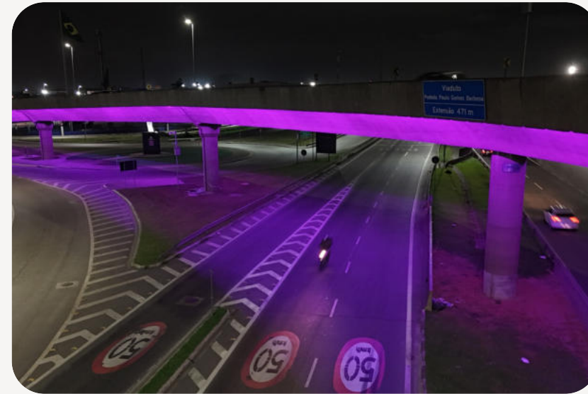
Viaduto Paulo Gomes Barbosa Santos/SP | Foto: Alberto Guijen (Drone Nacional)
